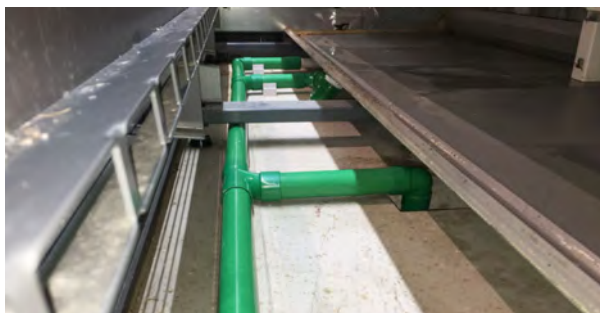
شکل ۱. نصب جدید لوله‌های تخلیه بیوپایپ با تکنولوژی نوآورانه برای یک دستگاه یخچال در سوپرمارکت - بریتانیا
